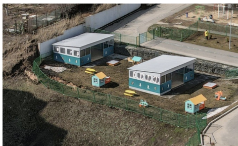
Рис. 2. Деформация грунта в мкр. Радужный г. Чебоксары
